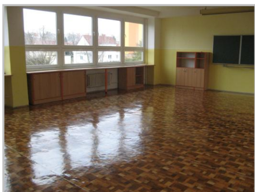
Třídy jsou vymalované, vygruntované a připravené k přestěhování žáků nazpět
