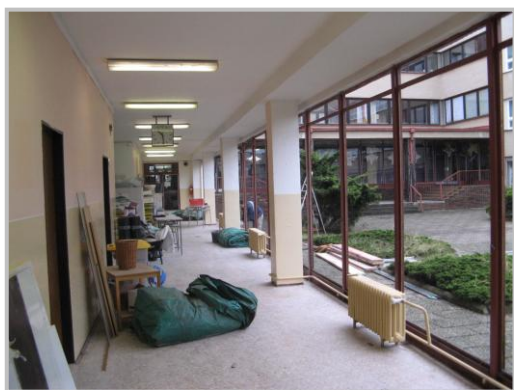
Počasí nám přálo, a tak přestavba probíhala bez problémů
