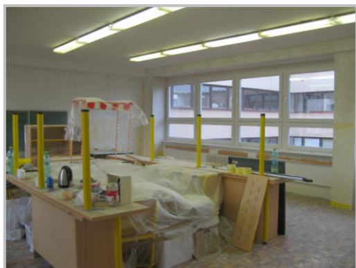
Okna jsou vyměněna, nastalo malování
